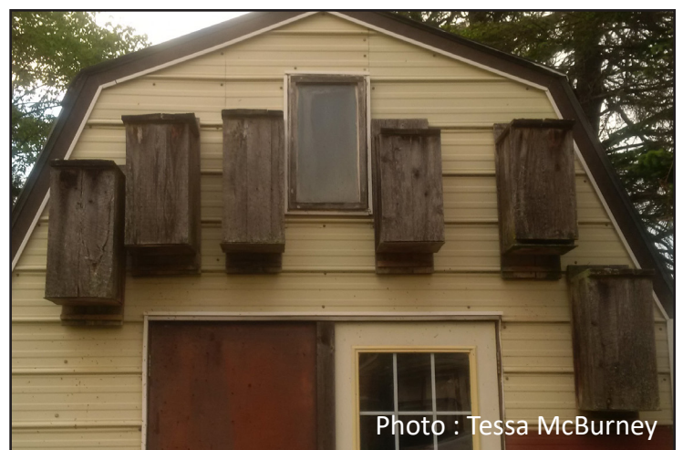
Figure 5. Installation d'un dortoir à chauve-souris.
